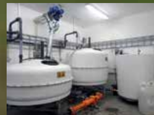
Big Dutchman restløs våtføring Vann i rørstreng mellom utføringer gir bedre førkvalitet. Ingen gjæring av restmengder i rørstreng. Mindre tap av aminosyrer som igjen gir lavere forforbruk/bedre tilvekst og økt dekningsbidrag.
