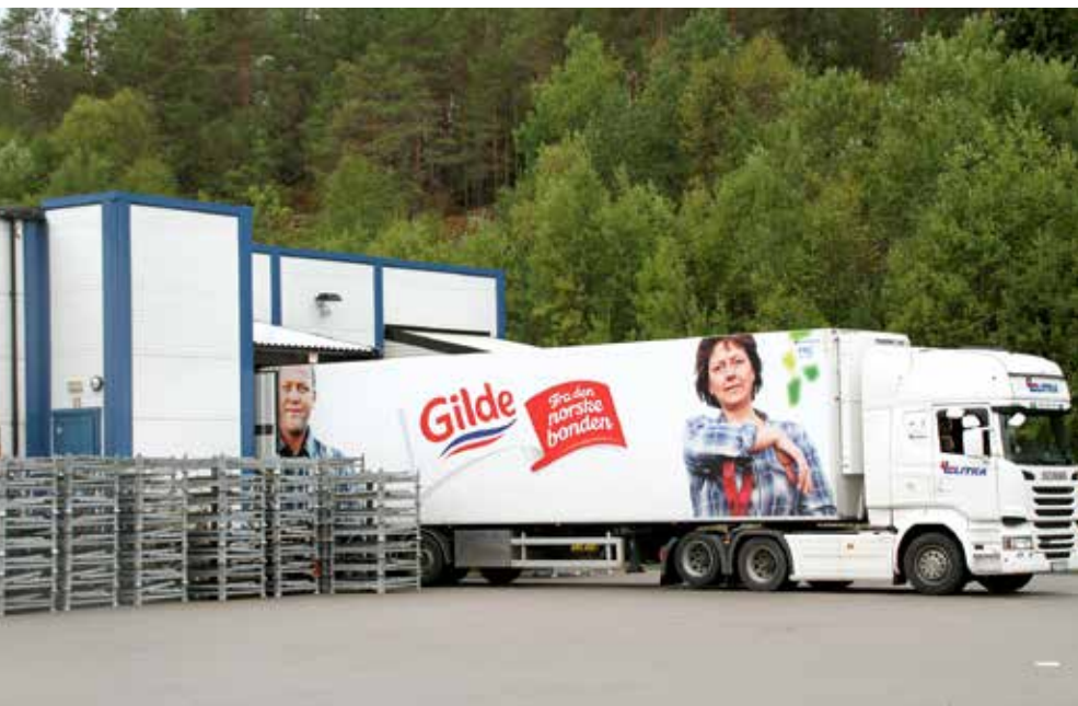
FRYSES INN: Til dette innfrysingsanlegget i Rakkestad kommer det blant annet svinekjøtt.
