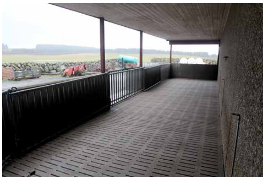
EGEN VEI: Det er egen vei inn til utlastingsrommet.
