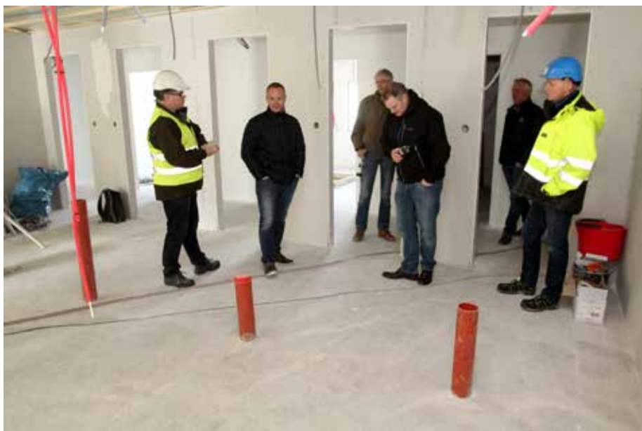
INNSLUSING: Alle ansatte og andre som har behov for å komme inn må hver gang dusje seg inn gjennom en av disse fem innslusingsrommene, forteller Svein Erik Stavne, råne- og semin-stasjonens daglige leder.
